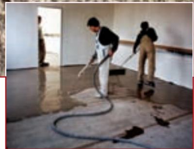
MAGNA STEYR csoport, Graz-Bécs Aljzatelőkészítés NIVORAPID-dal, ULTRAPLAN-nal, PRIMEG G-vel. Linóleum ragasztása AQUACOL-T-vel
